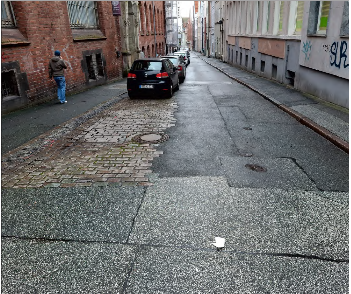
Abb. 3 Lübeck, Braunstraße, Verbliebener Rest eines hochwertigen Granitgroßsteinpflasters in ungebundener Bauweise (das übrige Pflaster wurde für den Wiedereinbau, nach Abschluss der Bauarbeiten im Gründungsviertel, eingelagert) – HL/Abt. Denkmalpflege/Klopp/2024.
