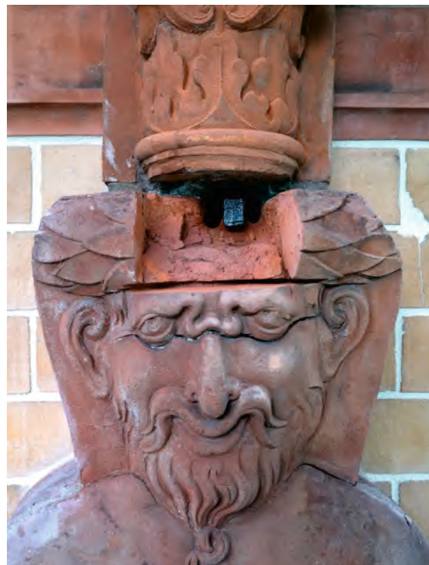
Abb. 6 Lübeck, Musterbahn 3, Straßenfassade Hier musste der Anker des Hermenkopfs freigeschnitten werden, der herausgeschnittene Teil wurde nach der Behandlung des Ankers wieder eingesetzt – HL/Abt. Denkmalpflege/Knipscheer/2024.
