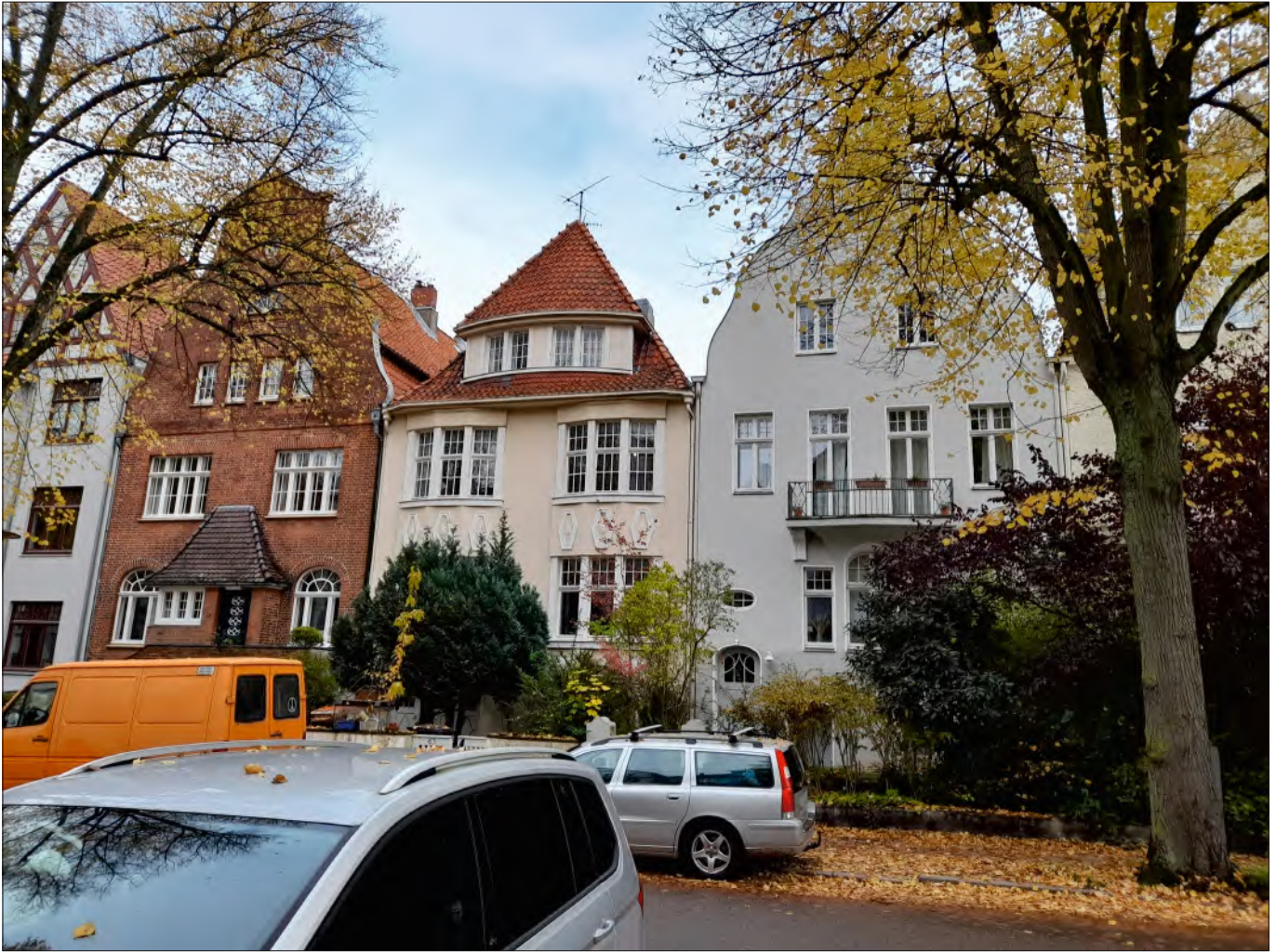
Abb. 3 Lübeck, Hohelandstraße, straßenseitige Fassaden der Mba – HL/Abt. Denkmalpflege/Seemann/2023.
