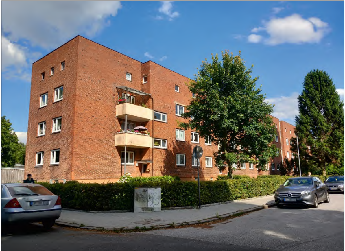
Abb. 2 Lübeck, Margarethenstraße 42-52, Vorderansicht, Kopfbau – HL/Abt. Denkmalpflege/Lutter/2024.
