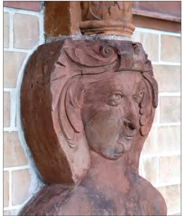
Abb. 9 Lübeck, Musterbahn 3, Straßenfassade, nachdem der Anker saniert war, wurden die Teile wieder zusammengefügt – HL/Abt. Denkmalpflege/Knipscheer/2024.
