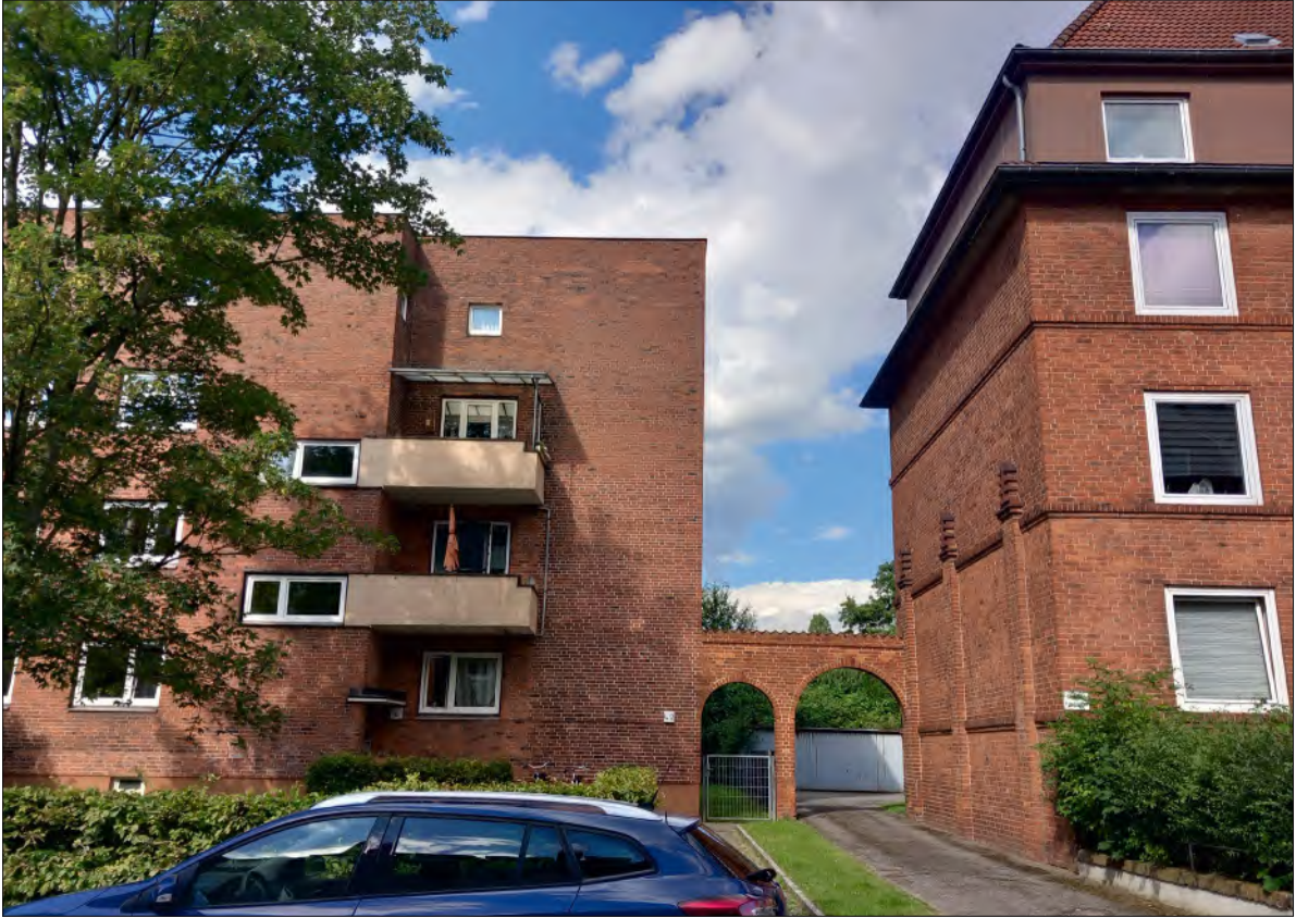
Abb. 4 Lübeck, Margarethenstraße, später eingefügtes Verbindungselement zwischen den Wohnblöcken – HL/Abt. Denkmalpflege/Lutter/2024.
