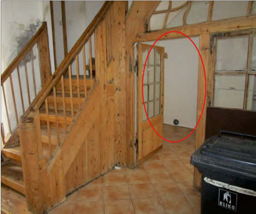
Abb.3 Lübeck, Kupferschmiedestraße 10, Diele und Treppenhaus vor der Freilegung – HL/Abt. Denkmalpflege/2019.
