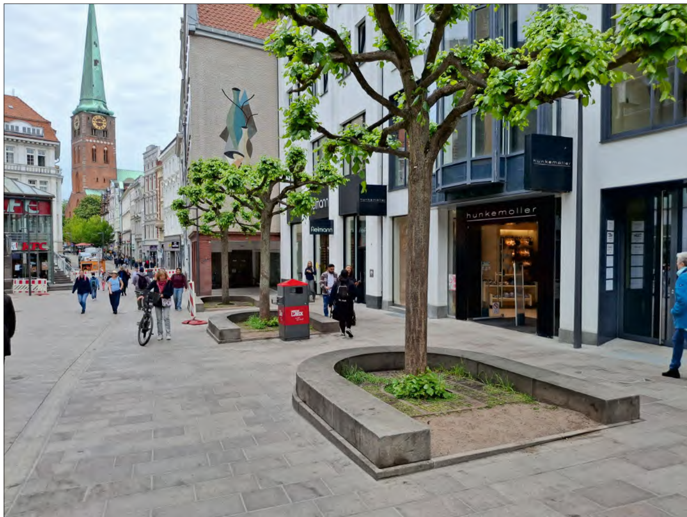
Abb. 6 Lübeck, Breite Straße, Neues, vollflächiges, helles Granitpflaster mit Betonunterbau, das Regenwasser wird fast vollständig und auch vor dem Stadtgrün weggeleitet – HL/Abt. Denkmalpflege/Klopp/2024.
