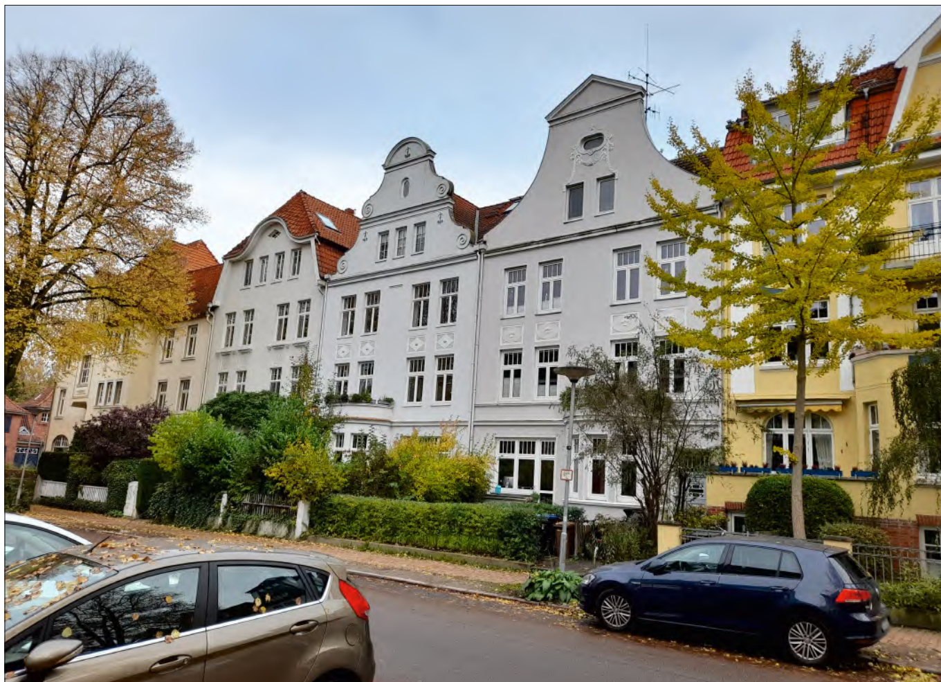
Abb. 2 Lübeck, Hohelandstraße, straßenseitige Fassaden der MbA – HL/Abt. Denkmalpflege/Seemann/2023.
