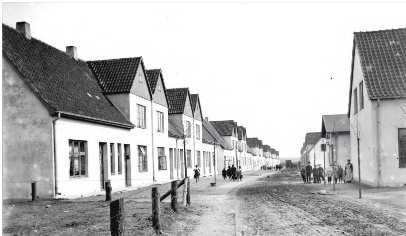
Abb. 8 Lübeck-Herrenwyk, Werkssiedlung, Ansicht von Westen in Eisenstraße kurz vor der Einmündung Brennerstraße, vor 1920 – HL/Fotoarchiv HL, B10432/vor 1920.
