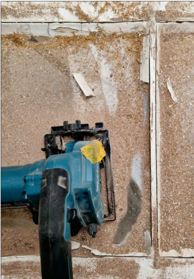
Abb. 2 Muss man auf den Rahmen keine Rücksicht nehmen, lässt sich die Scheibe deutlich leichter herauslösen. Hier wurde mit einer Tauchsäge hinter der Kittfuge gesägt, und zwar in den alten, einstmals aus dem Container geborgenen Fenstern der Kalandrschule. Deren Scheiben haben bei kleinen Unfällen zuverlässig Ersatz geliefert – Kiefer/Sellerbeck/2024.
