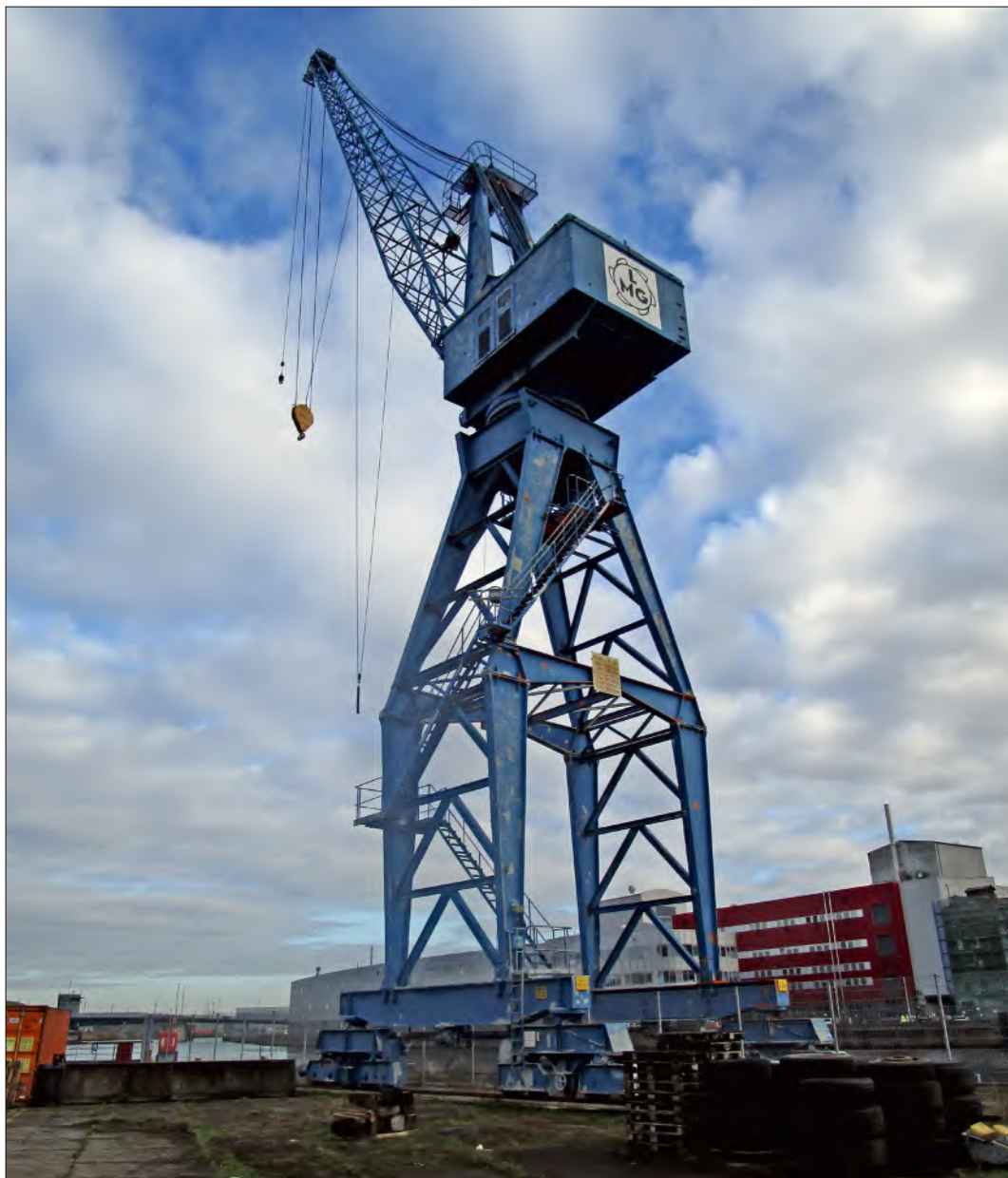
Abb. 4 Lübeck, Einsiedelstraße 6, Lübecker Maschinenbau Gesellschaft, Krananlage von 1952 – HL/Abt. Denkmalpflege/Köhn/2021.
