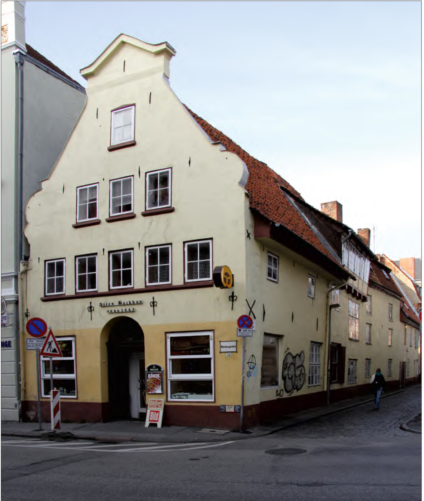
Abb. 3 Lübeck, Beckergrube 76/Böttcherstraße 34, Ansicht von Süden mit Blick in die Böttcherstraße – HL/Abt. Denkmalpflege/Reinhart/2011.
