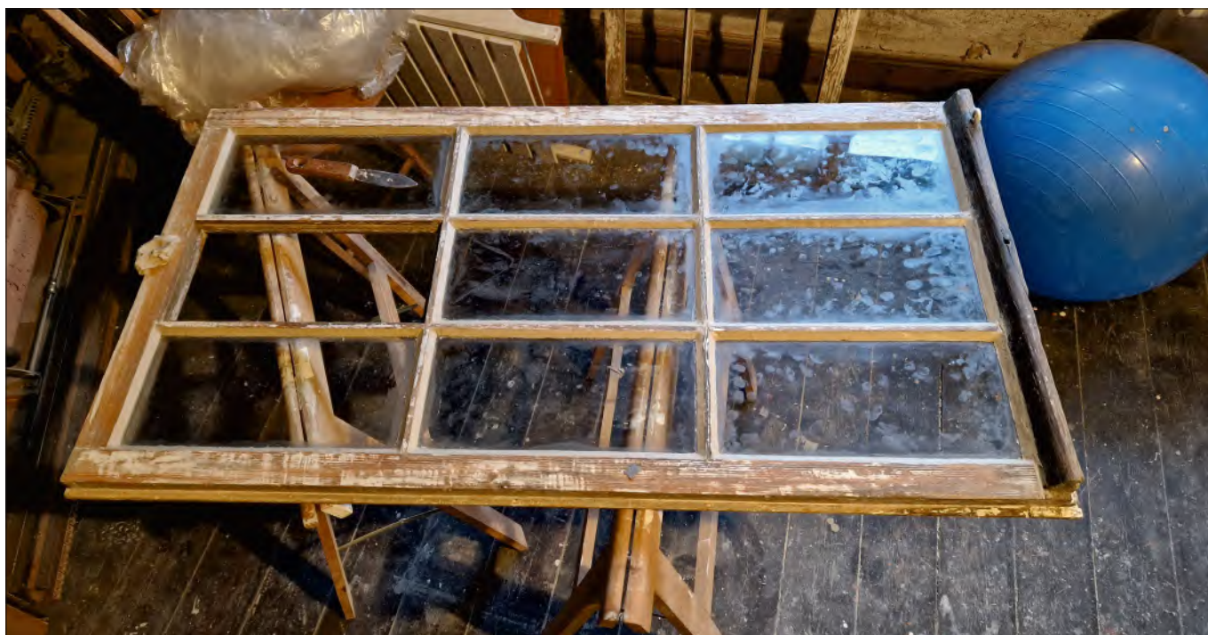
Abb. 4 Im Dachboden ließ sich ein Arbeitsplatz einrichten, welchen man bis in den späten Herbst nutzen konnte. Der Holzrahmen ist inzwischen geölt und hat bereits fast alle Scheiben wieder. Für viele Arbeitsschritte kann man das rückschonende Sitzmöbel rechts im Hintergrund hinzuziehen – Kiefer/Sellerbeck/2024.
