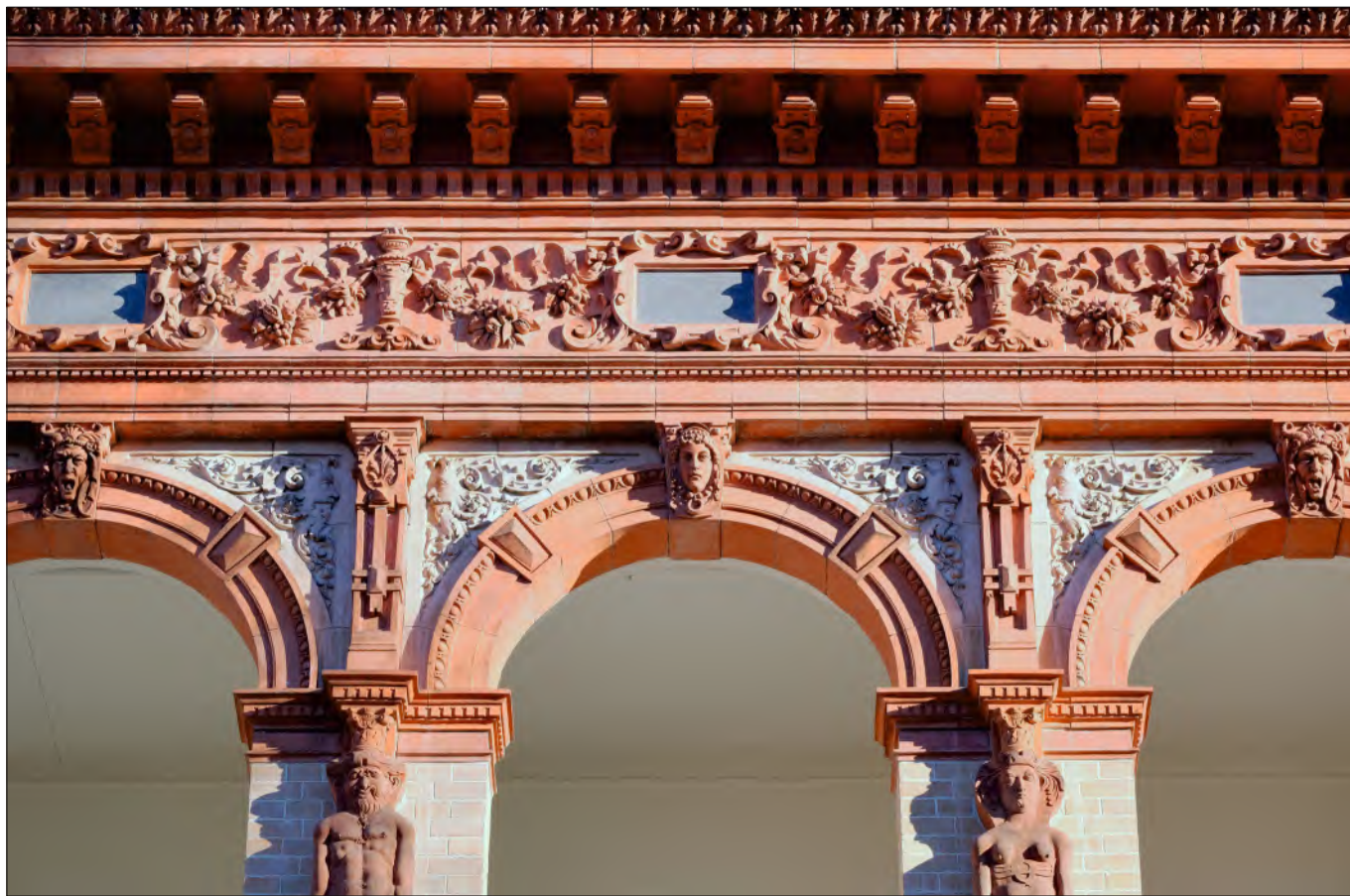
Abb. 10 Lübeck, Musterbahn 3, Straßenfassade, Nach den Reparatur- und Vorsorgemaßnahmen zeigt sich die Straßenfassade wieder mit ihrer beeindruckenden Detailvielfalt – HL/Abt. Denkmalpflege/Knipscheer/2025.
