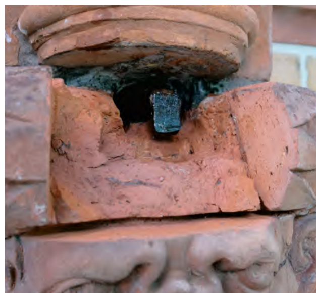
Abb. 7 Lübeck, Musterbahn 3, Straßenfassade entrosteter und mit Rostschutzmittel behandelter Anker – HL/Abt. Denkmalpflege/Knipscheer/2024.
