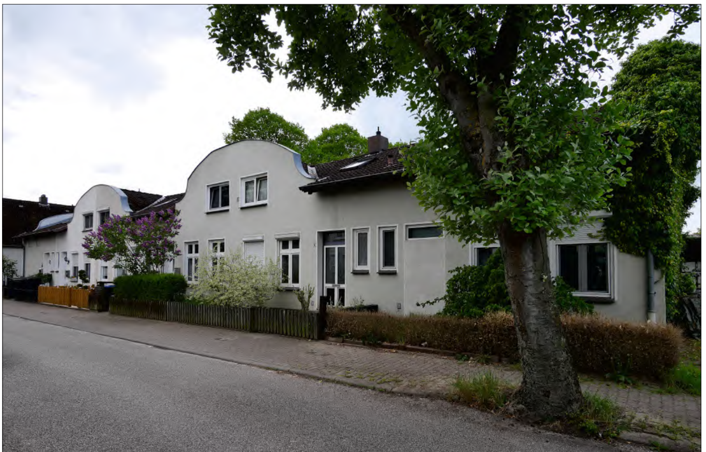
Abb. 5 Lübeck-Herrenwyk, Werkssiedlung, Beispiel für Acht-Häusergruppe – HL/Abt. Denkmalpflege/Ellersiek/2025.
