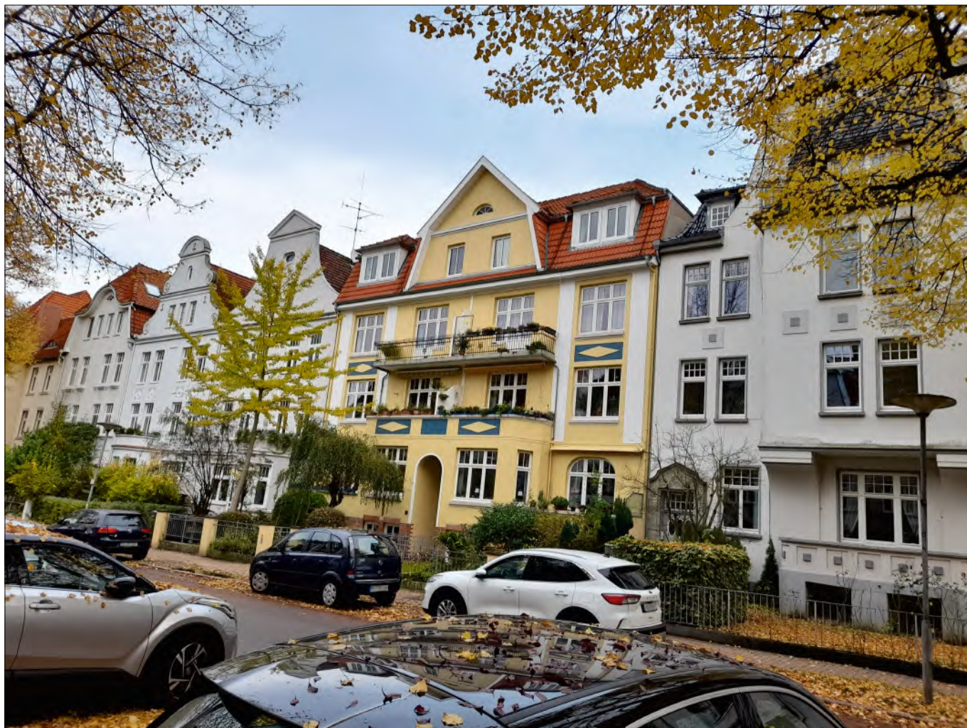
Abb. 4 Lübeck, Hohelandstraße, straßenseitige Fassaden der MbA – HL/Abt. Denkmalpflege/Seemann/2023.
